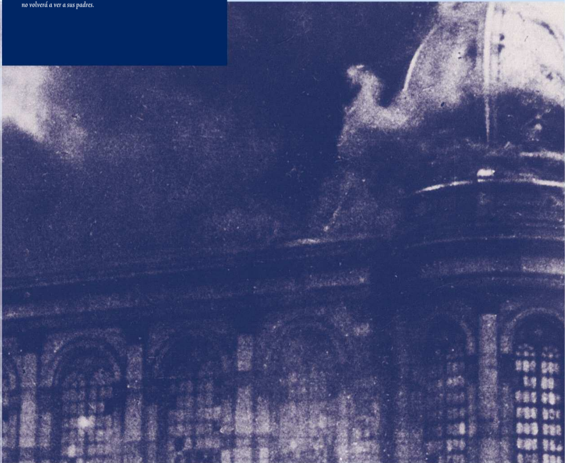
La sinagoga de Francfort del Meno arde en la noche del 9 al 10 de noviembre de 1938, la «noche de los cristales rotos».
