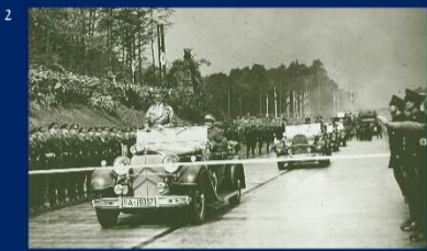
A los desempleados se les pone a trabajar en la construcción de autopistas, edificios del gobierno y obras públicas. Al mismo tiempo, Hitler comienza a desarrollar una industria de armamentos y a formar un gran ejército. El desempleo disminuye rápidamente.
